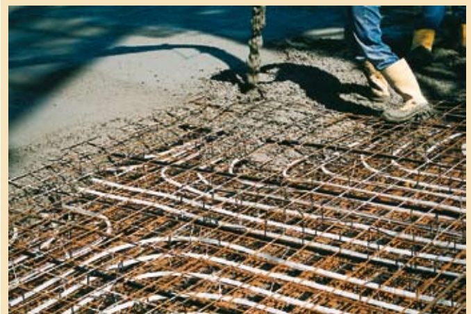
■ Die PE-X-Rohre der Betonkernaktivierung „Contec“ von Uponor sind in werkseitig vorgefertigten Modulen integriert und ermöglichen u. a. so einen schnellen Baufortschritt.
